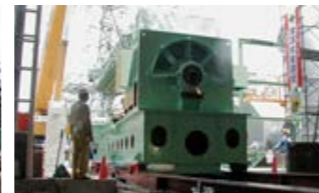
ディーゼル発電機設置
