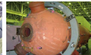
給水加熱器 解体除却減容
