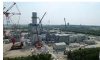
火力発電所建設
