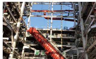
ジャックアップシステムによる施工
