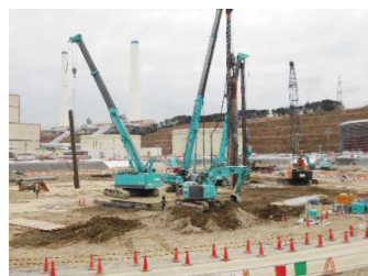
貯油タンク基礎他撤去工事 基礎こわしおよび杭抜き工事
