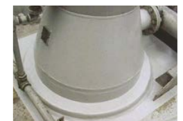
ケミシール工法による変圧器ブッシング本体部漏油修理状況
