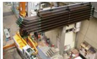
ボイラ設備修理
