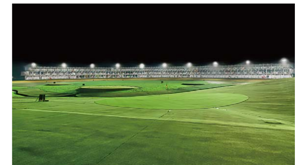
ゴルフ練習場照明のLED化工事
