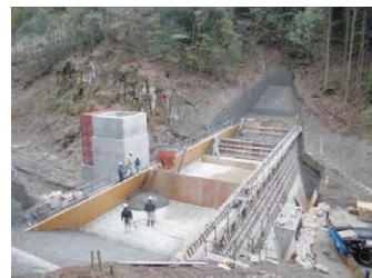
太陽光発電所 調整池ダム建設工事 高14m×長51m×幅2m(ダム天端)コンクリート2,700m 3
