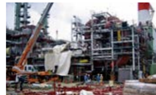
化学プラントボイラ据付
