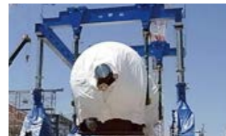
ガスタービン発電設備据付
