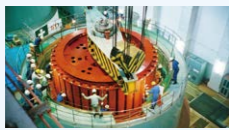
発電機ローター吊り込み
