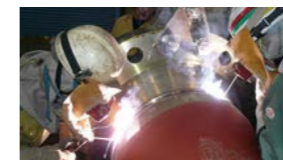
配管溶接作業
