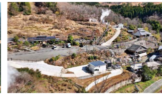
熊本県 地熱 99kW (ベースロードパワージャパン提供)
