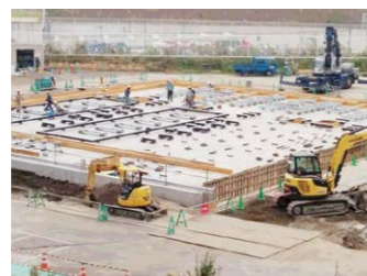
変電所新設工事
