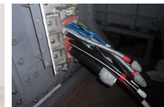
ケーブル貫通部止水対策
