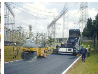
変電所構内舗装工事
