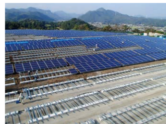
太陽光発電設備(2,500kW) (造成・基礎・架台・パネル設置・排水・外柵)
