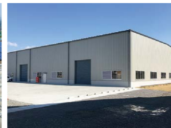
予備品倉庫新設工事
