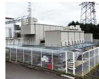
NAS電池システムの設置
