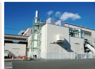
企業向けガス機関 コージェネレーション設備土木建築工事
