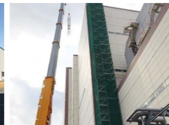
火力発電所 ボイラー建屋工事用エレベーター 設置工事
