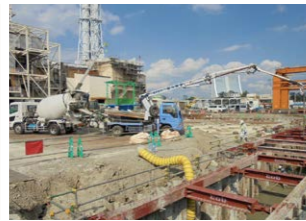
火力発電所 変電設備新設工事
