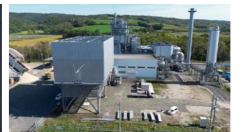
網走バイオマス発電所2号機
