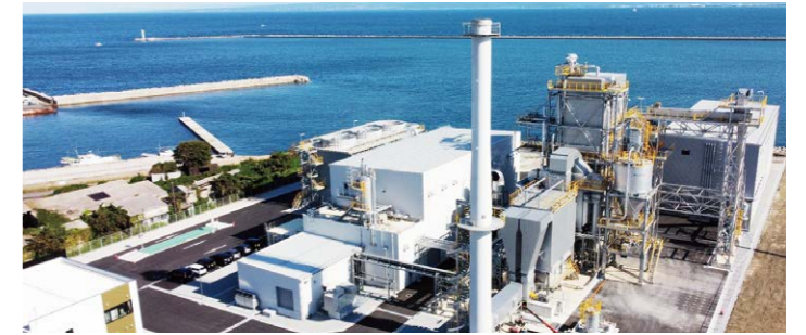
境港バイオマス発電所全景
