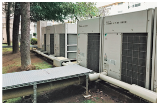
学校空調設備導入（室外機）
